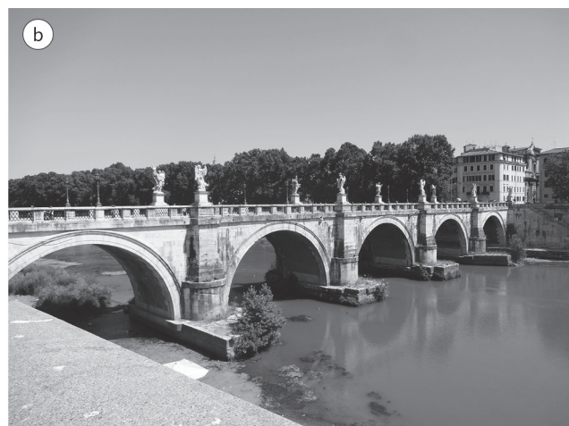
Ponte Sant'Angelo: em pedra, com cinco vãos totalizando o comprimento total de 135 m, concluída em 134
