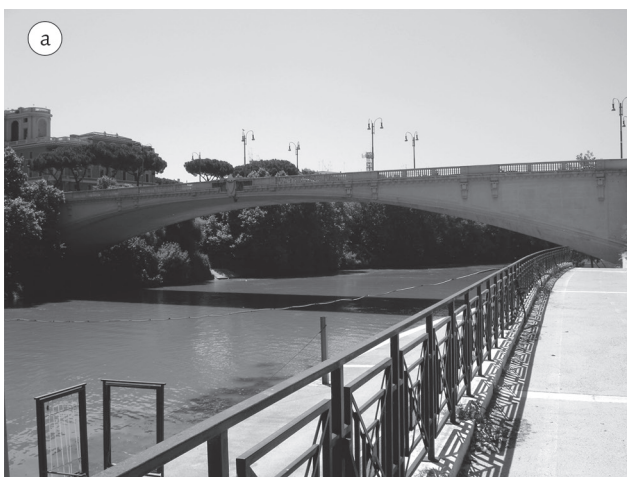
Ponte del Risorgimento: em CA, com vão de 159 m, concluída em 1911
