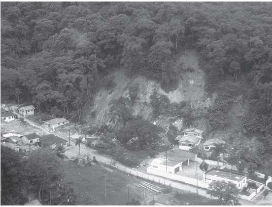
Fig. 1.10 Escorregamento de solo em um talude infinito com vegetação
