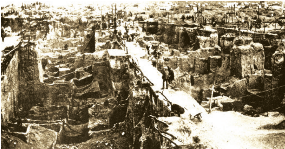
Fig. 1.5 A caótica mineração do pipe kimberlítico de Kimberley, África do Sul, em 1872. Foto de Williams (1906).
